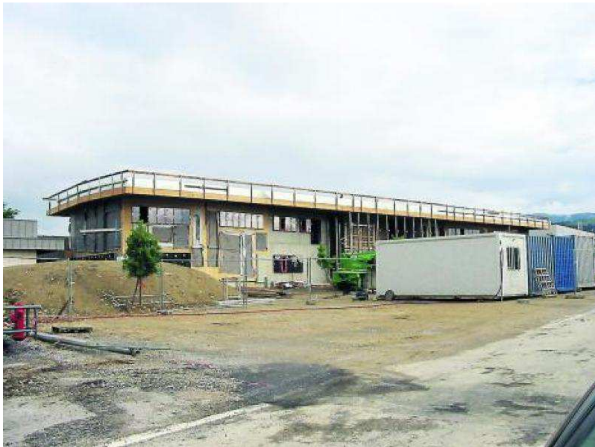
770 000 € sont nécessaires pour terminer les travaux du pôle scolaire./Photo DDM, B. M.
